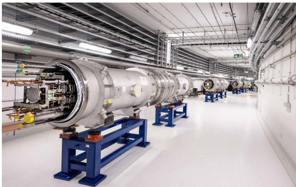
**FAIR-Beschleuniger: Die ersten supraleitenden Magnete für den zukünftigen FAIR-Beschleuniger wurden im ringförmigen Tunnel positioniert.**
