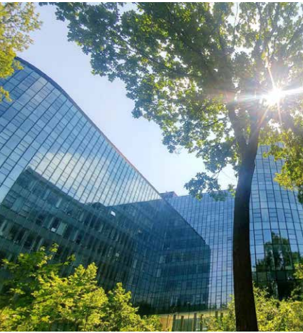
Bürogebäude Main Airport Center Bild: FRM GmbH/ Michaela Stork
