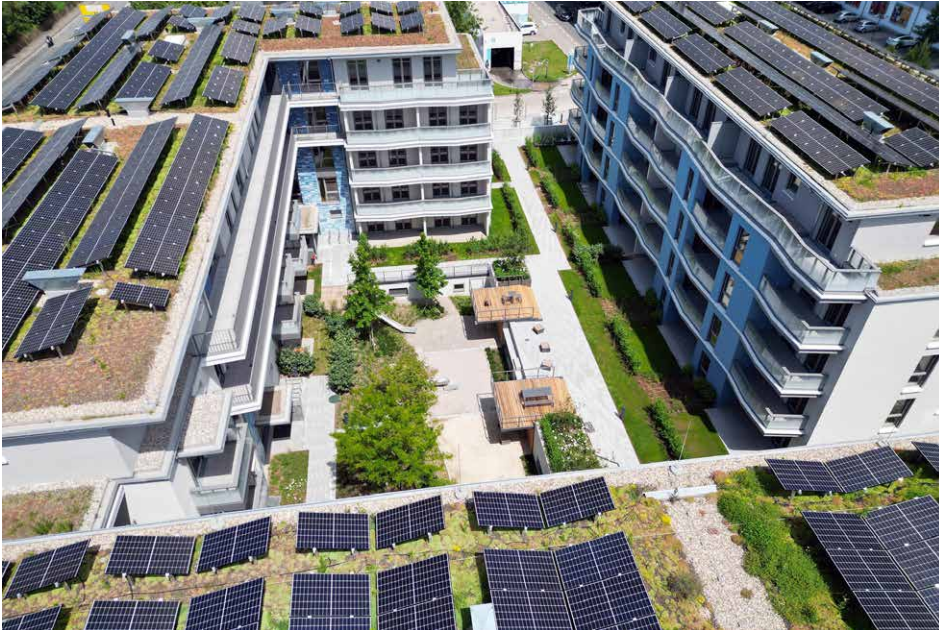
Photovoltaikanlage auf der Neubauwohnanlage des TÜV Hessen Trust e.V., Bild: TÜV Hessen
