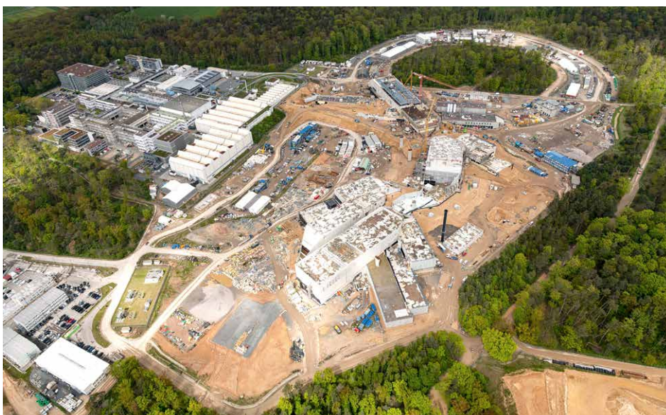
FAIR-Baustelle aus der Luft, April 2024. Bild: D. Fehrenz, GSI/FAIR
