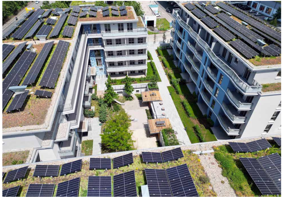
Photovoltaikanlage auf der Neubaubauwohnanlage des TÜV Hessen Trust e.V. Bild: TÜV Hessen
