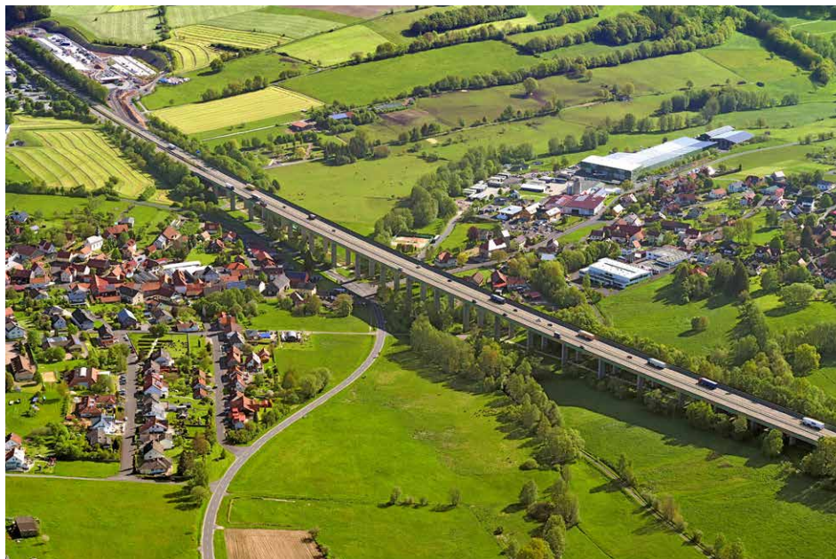
Talbrücke Uttrichshausen aus südwestlicher Richtung Bild: DEGES / Hajo Dietz
