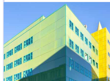
Ansicht des Mendini-Gebäudes, Sitz des DZHW Hannover Bild: DZHW GmbH / Petra Nölle
