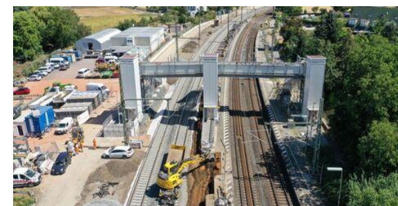
Viergleisiger Ausbau der S6 bis Friedberg
